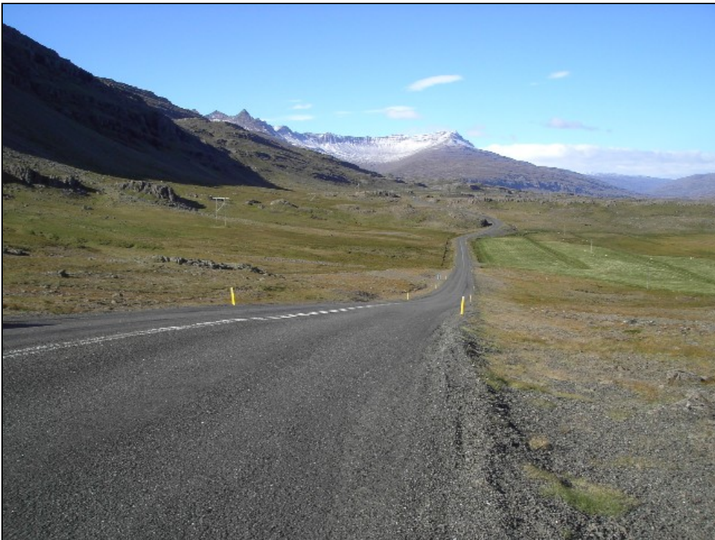
Mynd 2. Horft til vesturs eftir núverandi vegi. Ný veglína kemur u.þ.b. mitt á milli núverandi vegar og rafmagnslínu.
